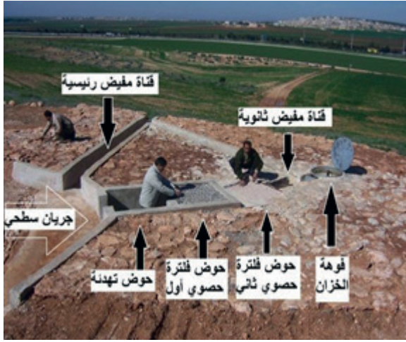
بناء الخزان الأرضي
