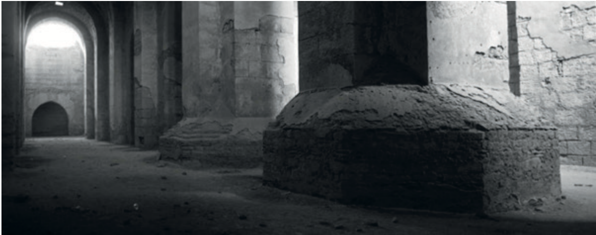
الشكل 13: "الخزان الكبير" في الرصافة، سوريا. تم ملؤه عن طريق توجيه الفيضانات الدورية من وادٍ غربي المدينة إلى الصهاريج وبسعة 18,000 متر مكعب.
